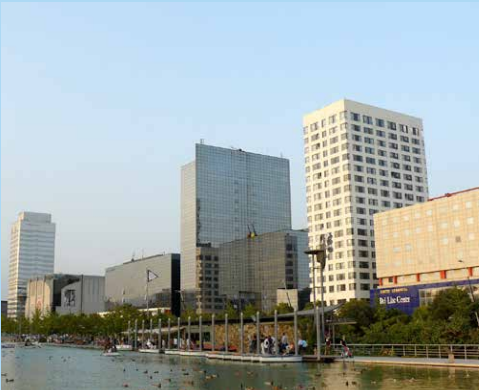
Vista general del Eix Macià (Eje Macià). Sabadell.
