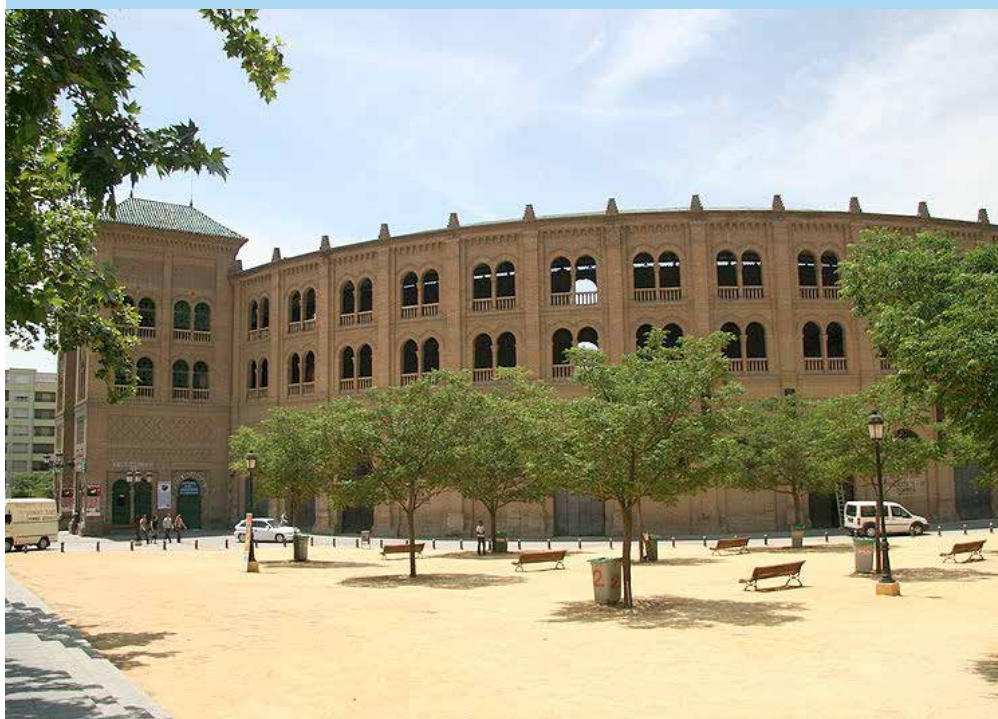
Plaza de toros de Granada, construida en 1928 en estilo neo mudéjar.
